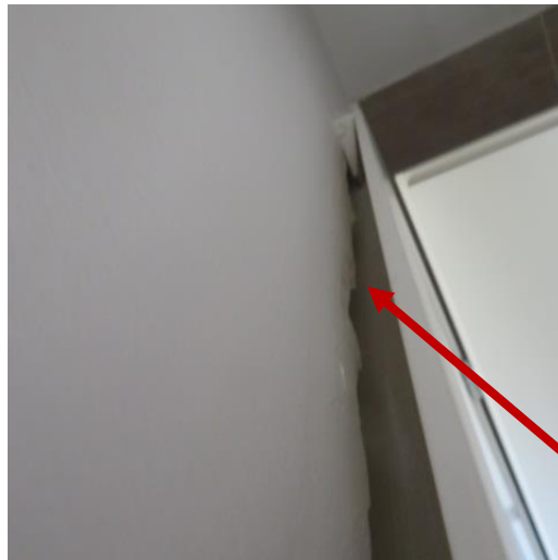
7.3.3. גימור לקוי ולא אסתטי פינה חדה בדופן האמבט התיקון: יש לבצע גמר אסתטי
