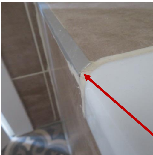
7.3.3. גימור לקוי ולא אסתטי פינה חדה בדופן האמבט התיקון: יש לבצע גמר אסתטי
